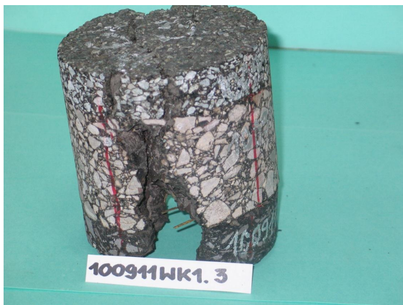
Rysunek 2 „Przedwczesne” zakończenie siatki zbrojeniowej w jednej ze spękanych lokalizacji.
